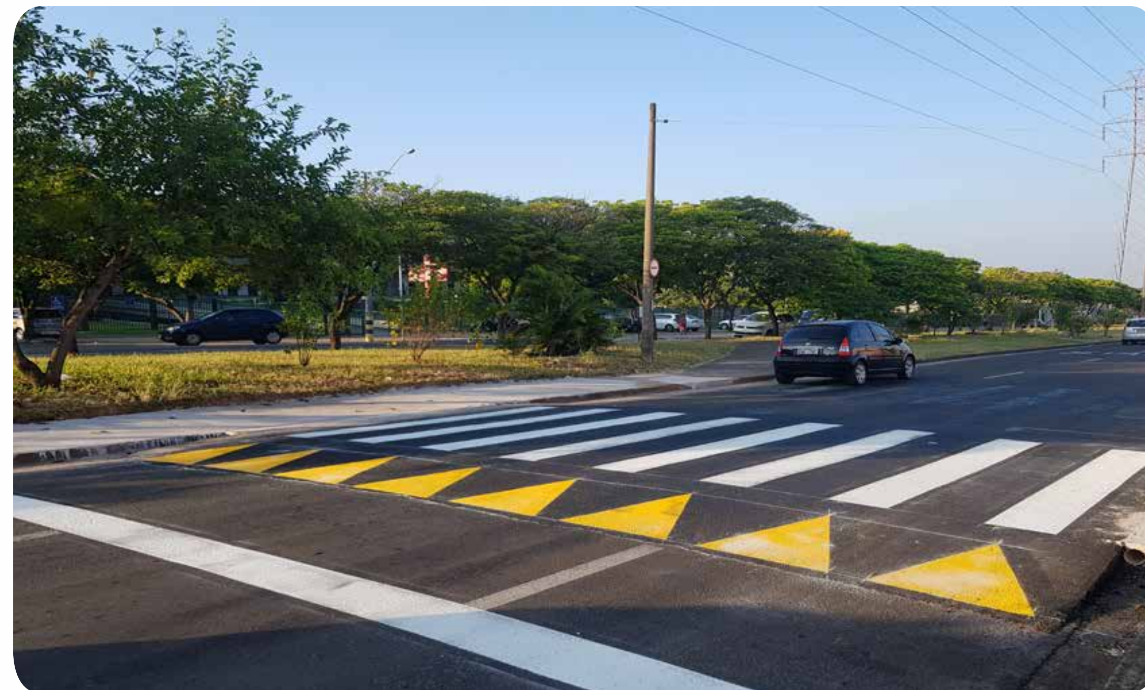
A nível da calçada
